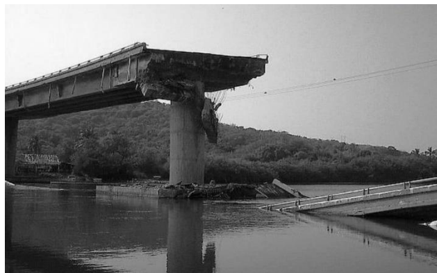
Mexiko, 2003: Brückeneinsturz infolge Wasserstoffversprödung
